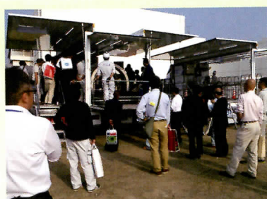
■ デモ施工車による製管実演に興味津々
